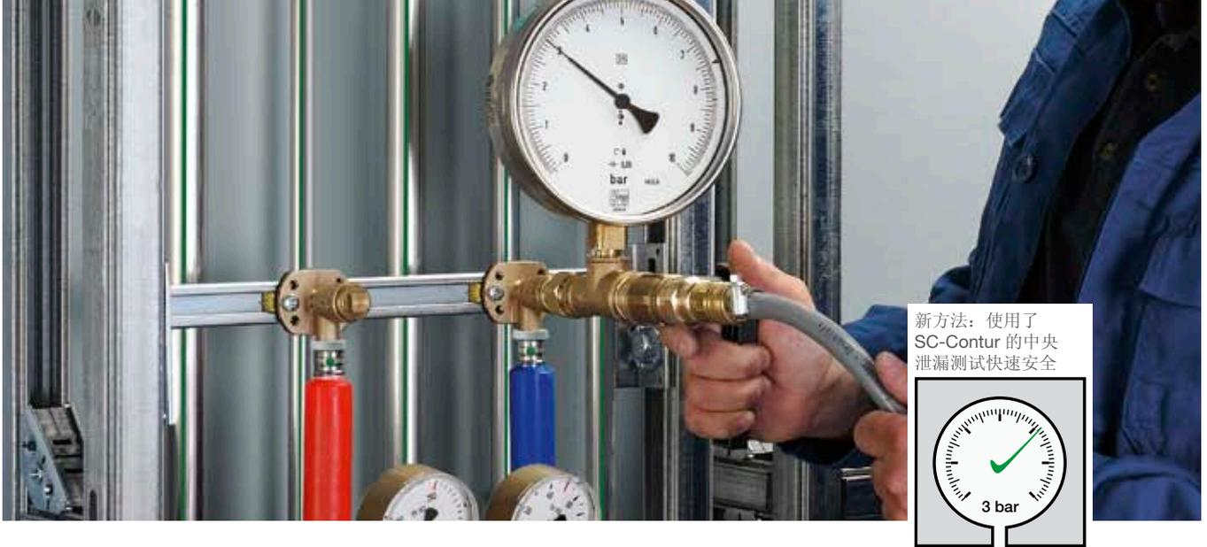
新方法：使用了 SC-Contur 的中央泄漏测试快速安全
