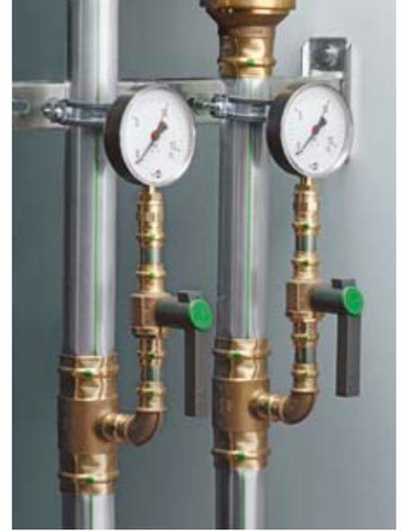
无论是在饮用水安装领域、工业领域、或是设备安装工程，Viega Sanpress 都具有新水准和高成本效益。其红色黄铜卡压接头结合 Sanpress 管道 AISI 444 (DIN 1.4521)，适用于各类饮用水安装。该系统提供的各种产品，可轻松满足您的日常需求。
