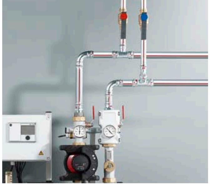
Viega Prestabo 的高度可靠性和安全性亦为专业人士知晓。这种由外部镀锌钢制成的卡压系统，其尺寸 15 mm 到 108 mm 之间、其中还包括中等尺寸 64 mm。Prestabo 是采暖安装、封闭冷却回路或压缩空气系统的经济型替代方案。它在压接时无需耗时焊接，但仍可快速安全进行压紧，就像所有 Viega 卡压系统那样。
